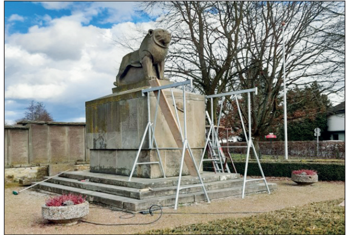
Das Denkmal bei der Sanierung.
